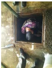
การสูบลบตะกอน และไขมันจากกระบบบำบัดน้ำเสีย
