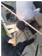
การสูบลบตะกอน และไขมันจากกระบบบำบัดน้ำเสีย
